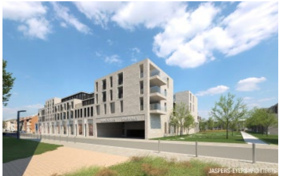
De Minckelersparking verdwijnt ondergronds. (Foto: Jaspers-Eyers Architects)
