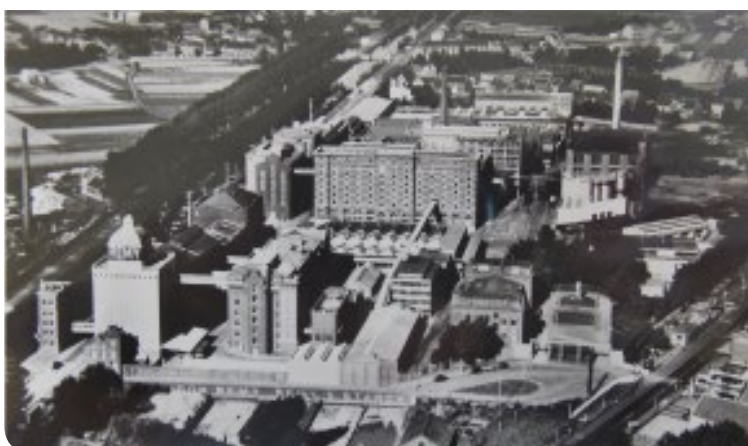
De enorme industriële site van Remy in Wijgmaal.
