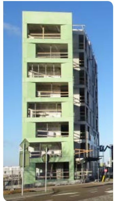
Vlakbij de Tiensesteenweg wordt aan de Spoordijk momenteel een nieuwe studentenresidentie gebouwd die zowel aansluit op de Spoordijk als op de groene parkzone. (foto Dyls Construct).
