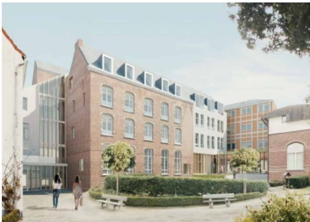
Het project op de site van de Zusters van Maria omvat zowel nieuwbouw als renovatie en combineert historische en moderne gebouwen. (Foto: a2o-architecten)
