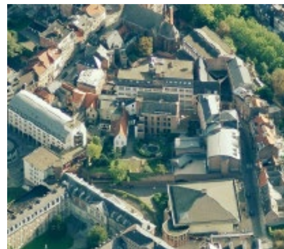
De bouwwerf is enkel bereikbaar via een smalle straat, wat onder meer uitdagingen met zich meebrengt voor de toelivering van materialen. (Foto: a2o-architecten)
