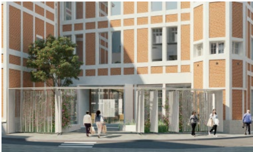
De huidige grijze muur in de bocht van de smalle Charles Deberiotstraat verdwijnt en maakt plaats voor een moderne open structuur. (Foto's: a2o-architecten)
